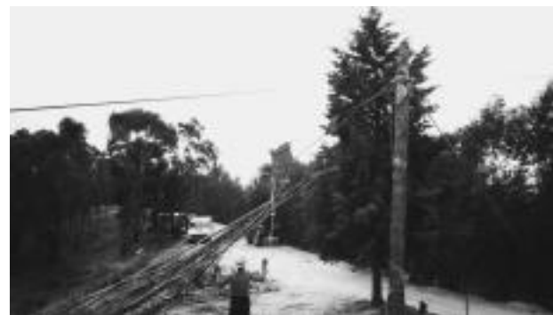
Fig. 3 - Zona di scarico del materiale dall'impianto di gru a cavo, ritto di monte e carrello.
